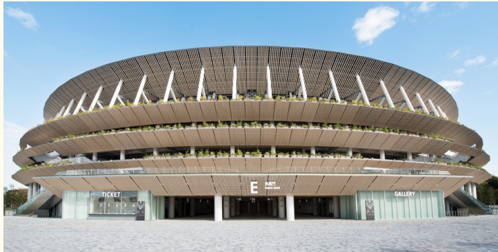
完成した新国立競技場(出典は日本スポーツ振興センターのHP)
