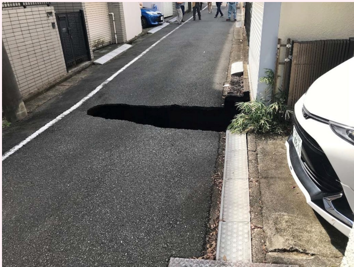
調布市内陥没事故の現場（出典：NEXCO東日本）
