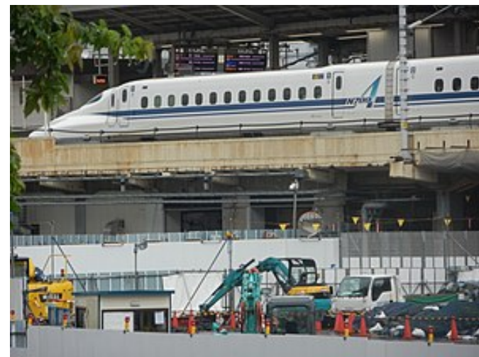
名古屋駅新幹線側の工事現場 (2019年8月)
