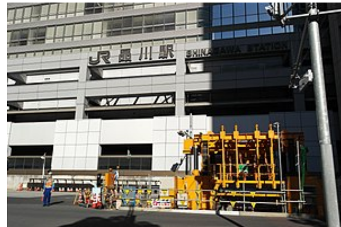
品川駅港南口側の工事現場 (2019年7月)
