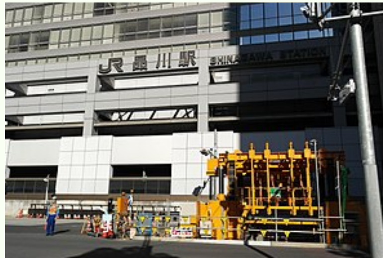
品川駅港南口側の工事現場 (2019年7月)
